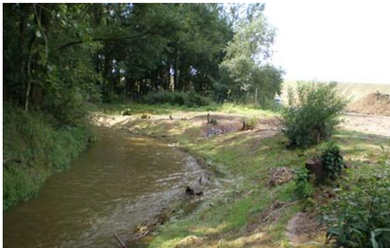
Abb. 88: Aufweitung des Querprofils in einem Mittelgebirgsbach (Foto: M. Schmidt)
