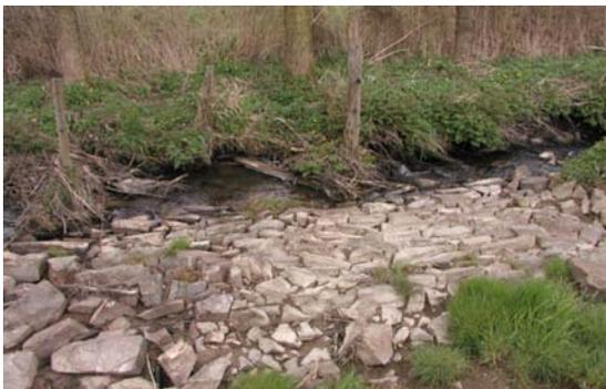
Abb. 45: Laufabschnitt im Mittelgebirge mit umläufigem Sohlenverbau (Foto: U. Koenzen)
