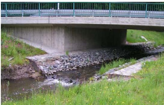
Abb. 65: Sohlabsturz an einer Brücke mit negativer Auswirkung auf die Durchgängigkeit (Foto: M. Dittrich)
