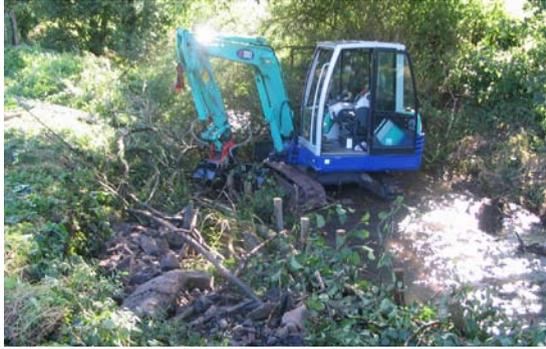
Abb. 71: Einbau eines Raubaums zur Ufersicherung
