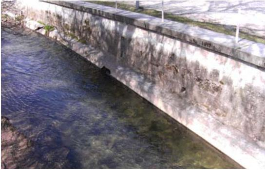
Abb. 67: Am Prallufer stark unterspülte Ufermauer der Bode im urbanen Umfeld
