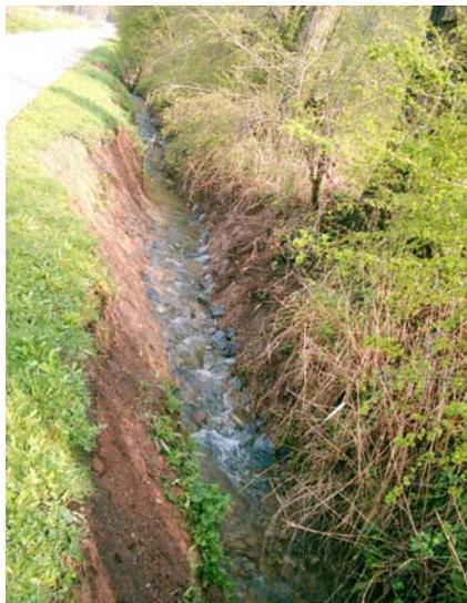
Abb. 40: Sohlensicherung mit Steinschüttung aufgrund ausgeprägter Tiefenerosion (Foto: H. Thiemt)
