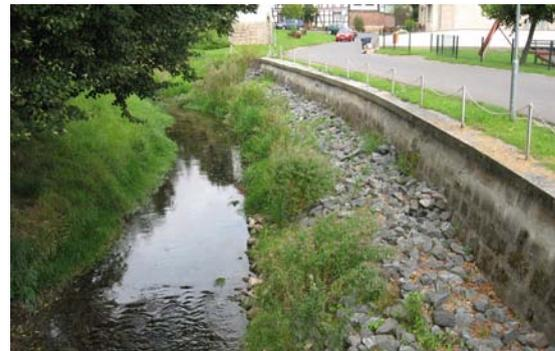
Abb. 68: Vergleichsfoto zu Abb. 67: Sanierter Zustand nach der Durchführung von Sicherungsmaßnahmen (Foto: H. Thiermt)
