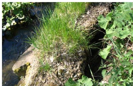
Abb. 78: Verfallende Betonsicherung
