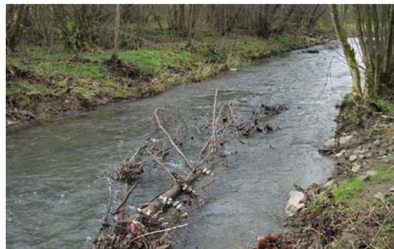
Abb. 39: Sohlensicherung durch Totholzeinbau (Foto: A. Kurth)
