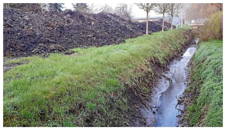
Auf einem Abschnitt von 1,8 Kilometern Länge ist die Roth am Rande des Gothaer Ortsteils Siebleben ausgebaggert worden, damit sie wieder fließen kann. Der herausgeholte Schlamm wird noch abgeholt und muss auf einer Deponie entsorgt werden.
