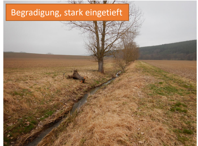
Fehlender Bewuchs (Gehölze) Trapezprofil
