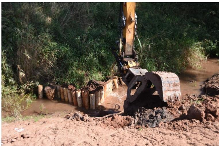
Abbildung 30: Strukturverbesserung der Sohle mittels Pfahlbühne
