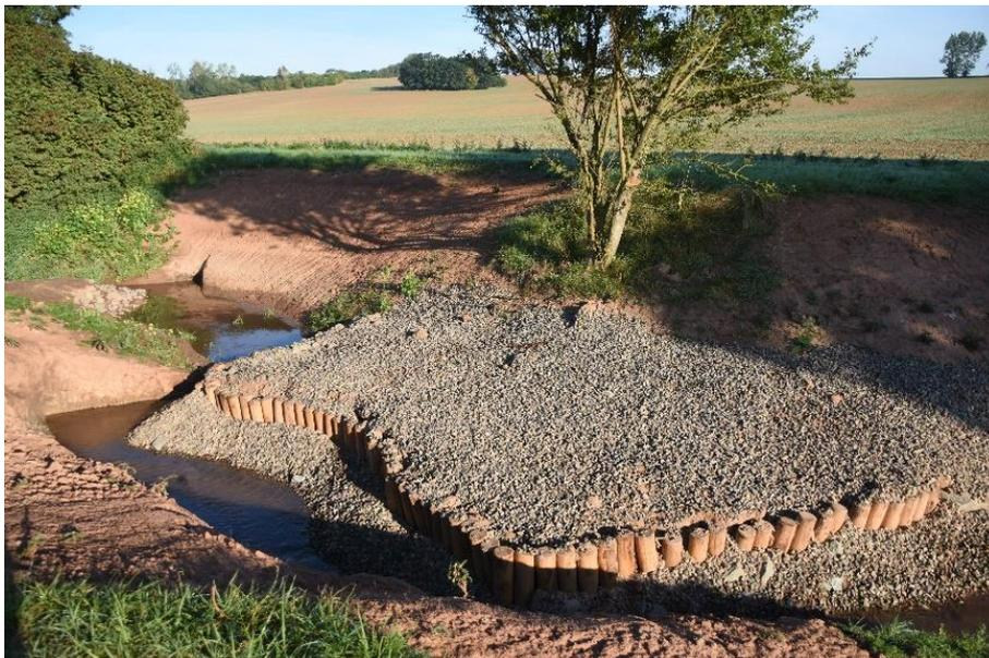
Abbildung 31: Beispiele für die Induzierung der Gleit- und Prallhangdynamik zur Verbesserung der Breiten- und Tiefenvarianz
